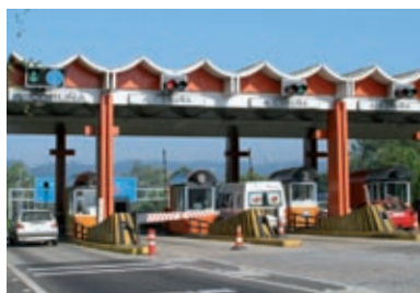
Manuelle und automatische Gebühren-/Mauteinhebungssysteme (manual and automatic toll collection systems)
